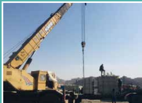
همکاری در اصلاح پروژه برق ۳۳ کیلو ولت کراشر
