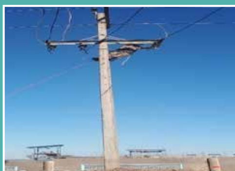
انجام پروژه اتصال خط هوایی تکمدا به دومداره جهت تامین برق شرایط اضطراری
